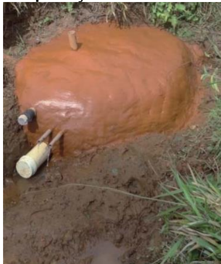
Figura 1. Técnica de proteção de nascentes em solo cimento.
