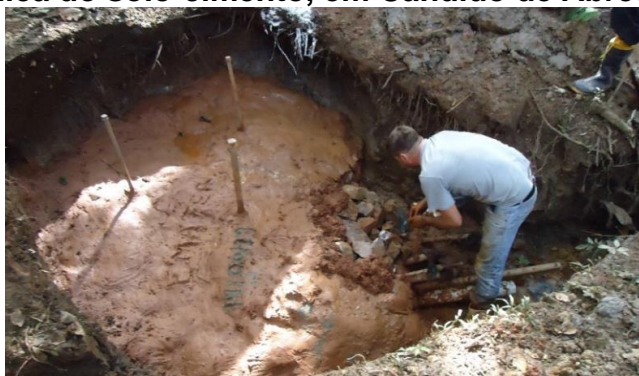
Figura 2. Nascente em Unidade Familiar em processo de proteção com a técnica do solo-cimento, em Cândido de Abreu, PR
