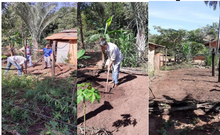
Figura 4. Preparo da área para montagem da composteira na Gleba 121 do Assentamento Mateira. Paraíso das Águas/MS
