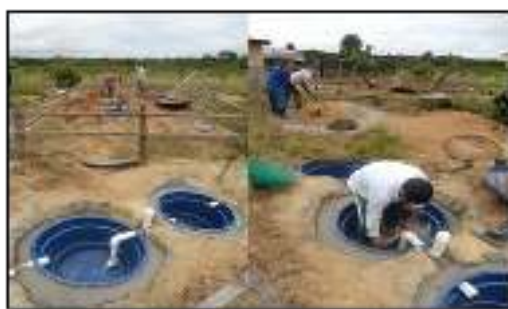
Figura 3. Reimplantação do sistema de fossa séptica utilizando concreto
