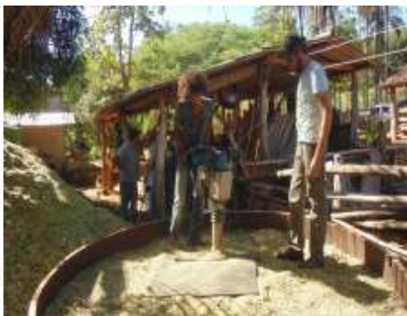
Figura 1 – Utilização de duas borrachas de 1 m 2 cada. e Figura 2 – Utilização de borracha do tamanho da fôrma.
