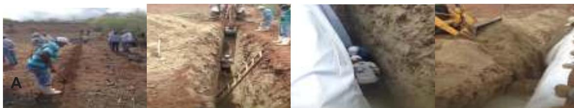
**Figura 1:**(A) Visão geral da escolha e demarcação da área; (B) Escavação e limpeza da vala; (C) Impermeabilização e fixação da lona na vala e (D) Enchimento ou fechamento da vala.
