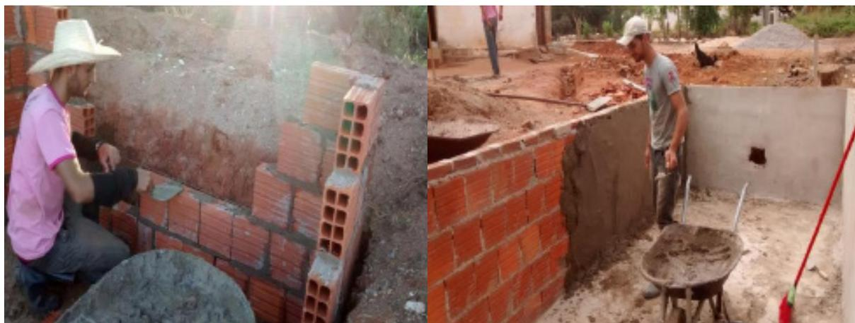
**Figura 2:** construção das paredes, pisos e reboco.
