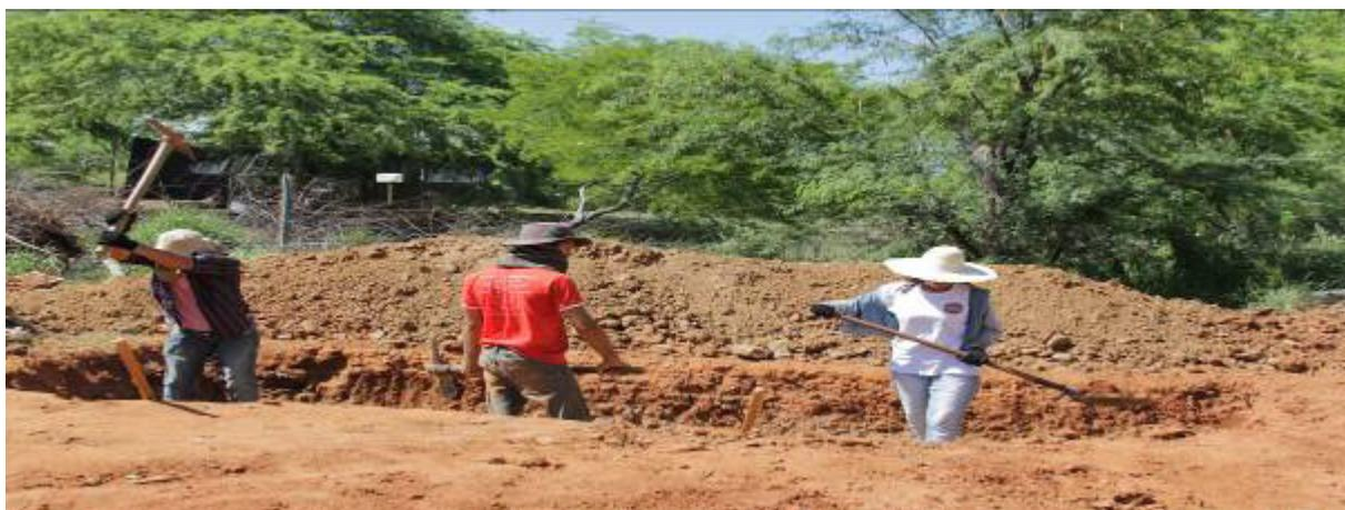
**Figura 1:** Escavação da trincheira para construção da BET
