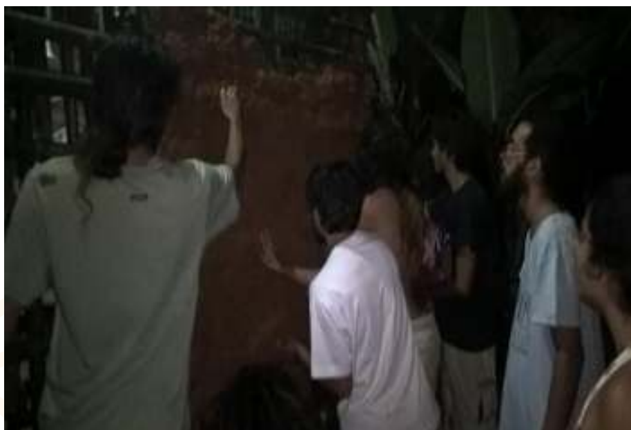
Imagem 3: Preenchimento das paredes de bambu-a-pique.
