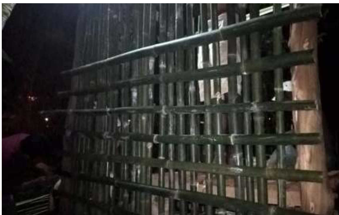
Imagem 1: Estrutura de bambu-a-pique
