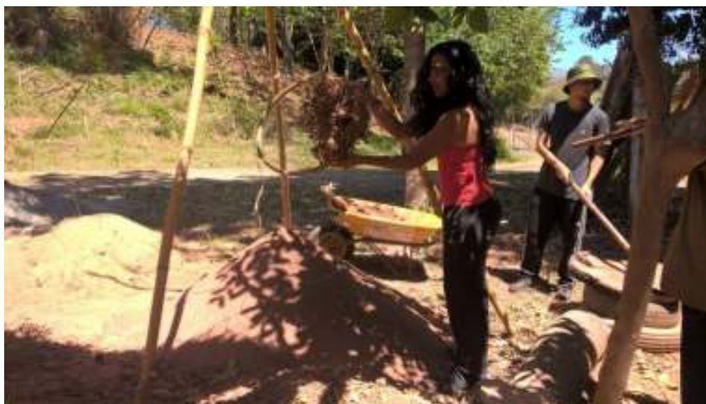
Imagem 4: terra sendo peneirada para o barro
