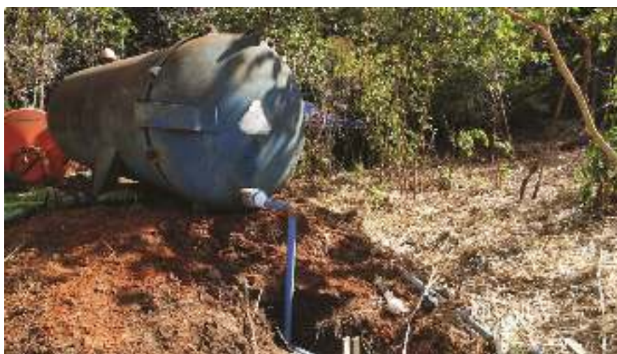
Figura 2 - Adaptação de reservatório de água para suprir a demanda por irrigação do SAF. Os técnicos de campo da Embrapa Milho e Sorgo Francimar Roberto da Silva e Vilmar Ferreira Martins foram os responsáveis pela idealização e instalação do sistema por gravidade, que será substituído por bomba movida a energia solar, em processo de instalação.
