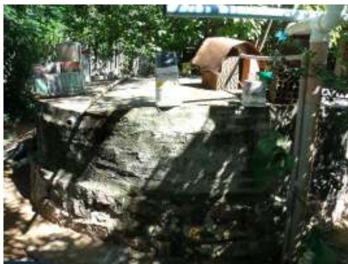
Figura 4 – Cisterna com capacidade para 36 mil litros.
