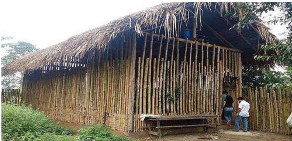
**Figura 1.** Viveiro recém construído para produção de ovos, com medições de 6 m de largura e 14 m de comprimento, área total de 84m<sup>2</sup>.
