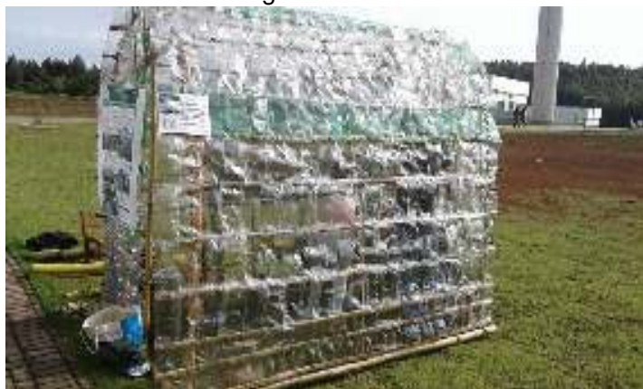
FIGURA 1. Estufa de garrafa PET e bambu.
