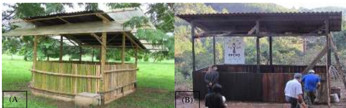
Figura 1. Estrutura alternativa à criação de suínos, denominada "Bambucilga" e construída utilizando bambu, solo cimento, cepilho e telhas reaproveitadas. A: Estrutura construída no Centro de Agroecologia, Pinhais – PR. B: Estrutura construída junto aos produtores de Rio Branco do Sul - PR.
