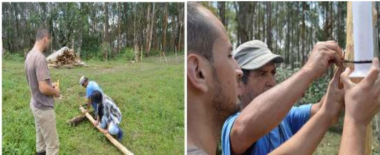
**Figura 2.** A. Construcción del pluviómetro en la familia Mestizo y B. Instalación del pluviómetro.
