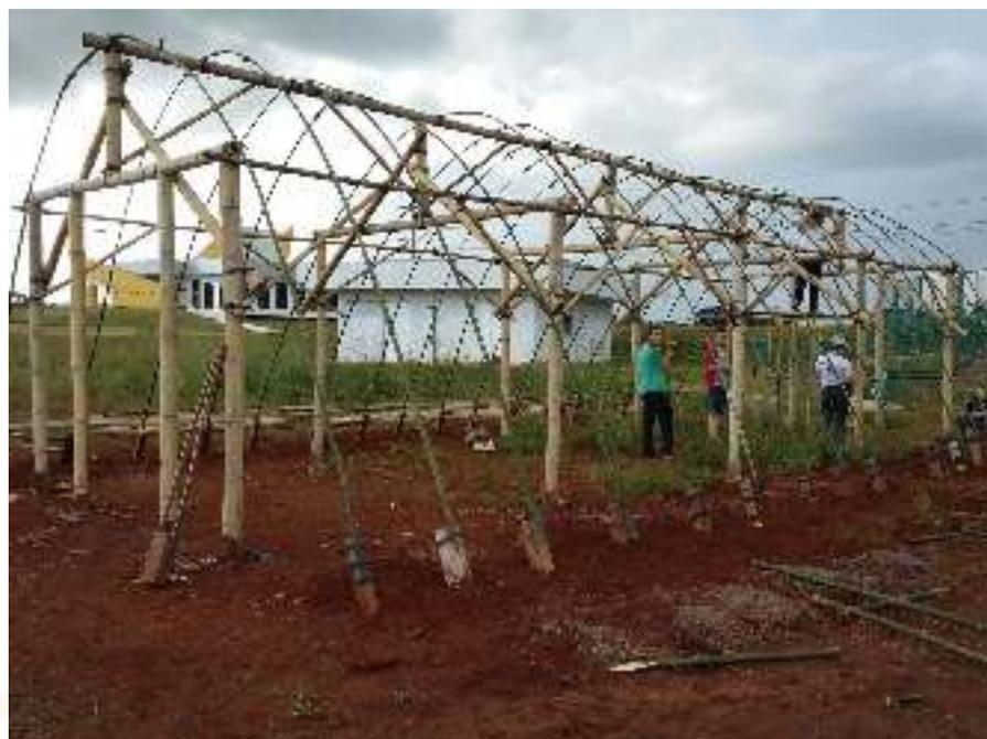
**Figura 4:** colocação dos arcos da estrutura.
