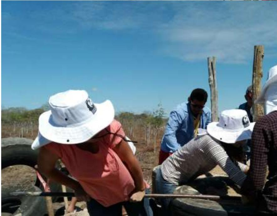
**Fotografia 01.** Utilizando o ferro de cova para facilitar o preenchimento dos pneus com areia. Fonte: Nardella Gardner (2017)
