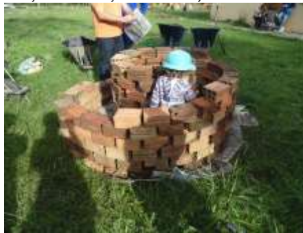
Figura 3. Espiral de ervas em construção Fonte: GEPP
