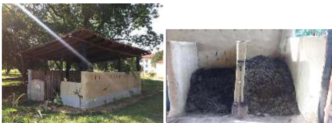
Figura 2 A e B. Vista lateral e interna do pátio de compostagem de resíduos orgânicos do projeto Composta Rural.
