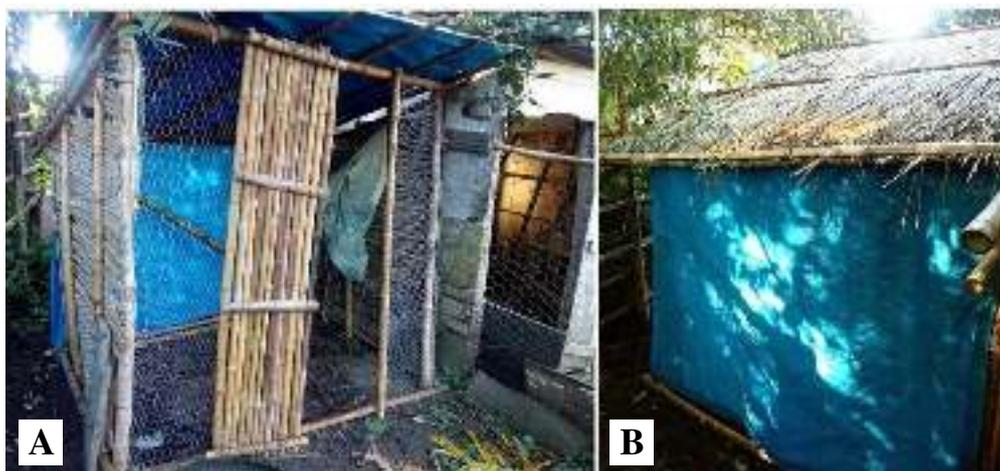
**Figura 3.** registros da parte frontal (A) e traseira (B) da estrutura após 10 meses de uso (18/04/2019)
