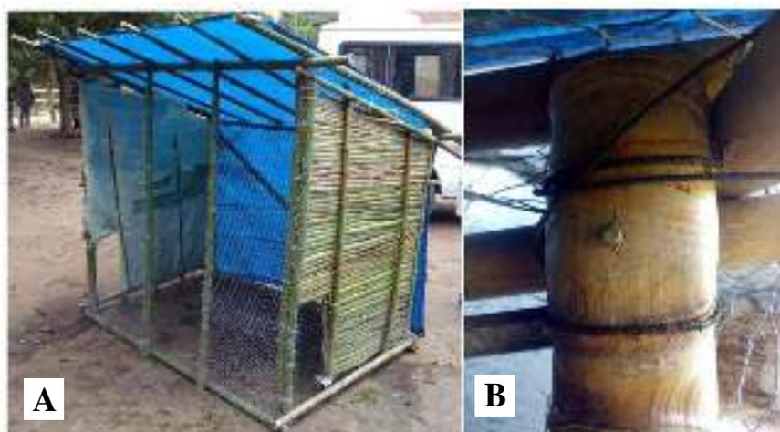
**Figura 1.** Visão frontal do aviário (A) e junções dos colmos com pino de bambu e arame (B).
