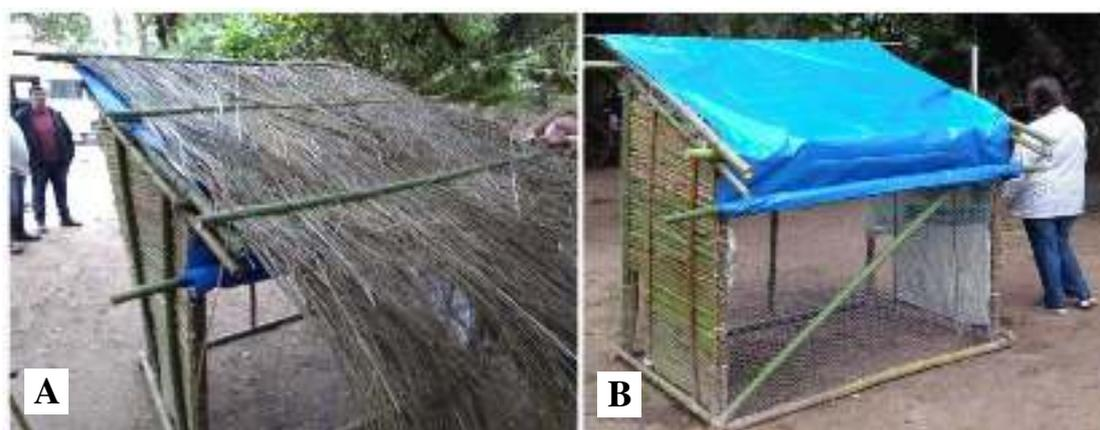
**Figura 2.** Capim Santa-Fé na parte superior (A) e visão traseira da estrutura expondo disposição da lona (B) (Fonte: autor)
