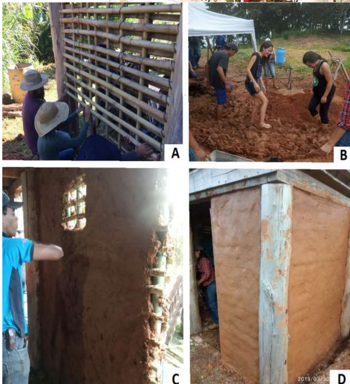
Figura 1. a. Montagem da estrutura da parede com bambu; b. preparo do barro; c. reboco da parede; d. acabamento nas paredes construídas.
