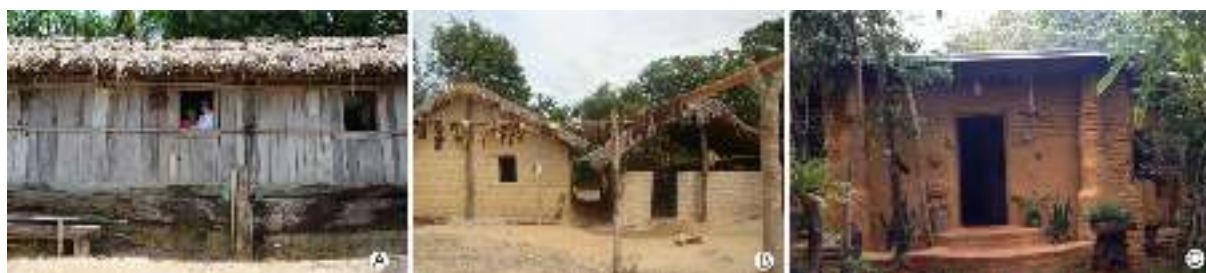
Figura 1 – (A) Casa da Dona Maria, PEC - TO; (B) Casa Comunidade Mumbuca do Jalapão - TO; (C) Casa Dennis, Palmas - TO.
