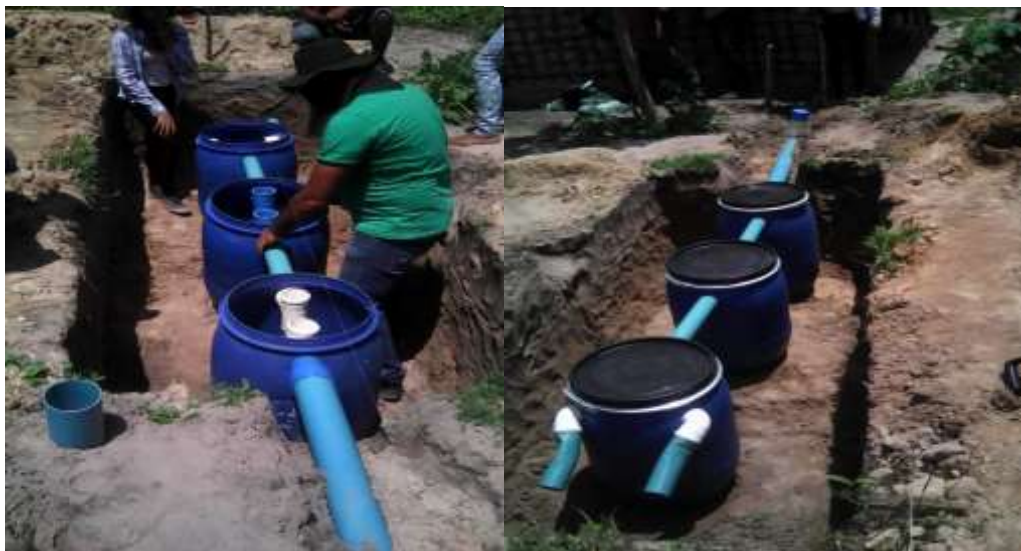
Figura 2. Esquema de instalação da Fossa biodigestora
