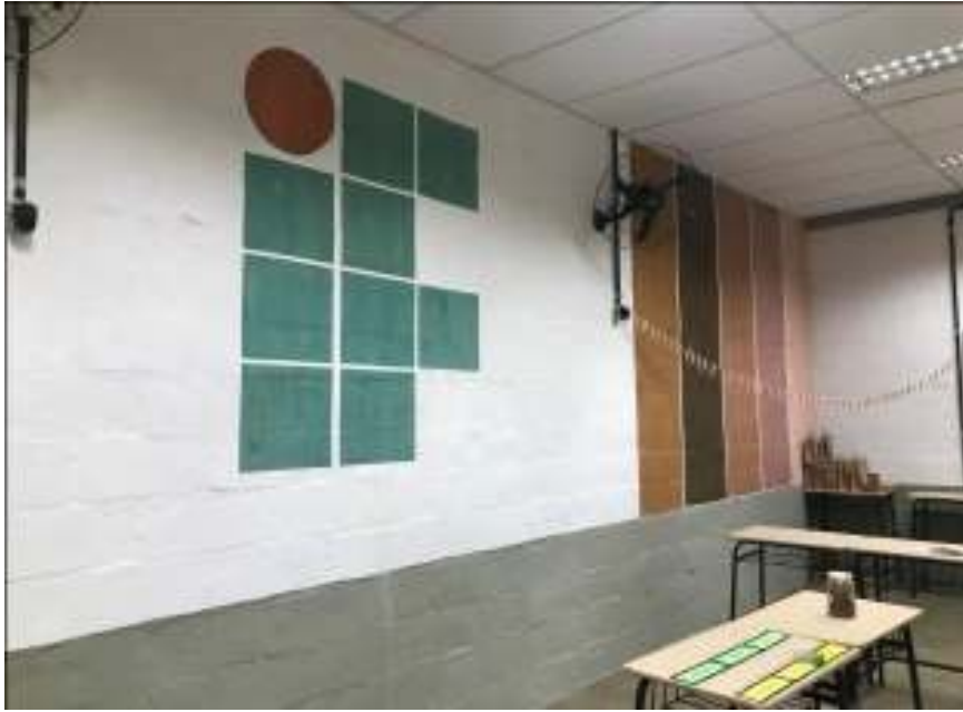
Figura 1. Paredes da Sala Pedológica pintadas com tintas sustentáveis feitas a partir do solo.
