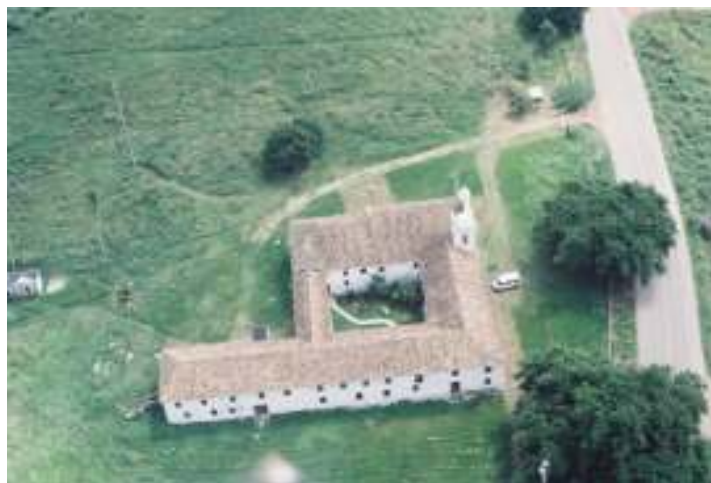
Figura 1 – Vista aérea do Solar dos Jesuítas.
