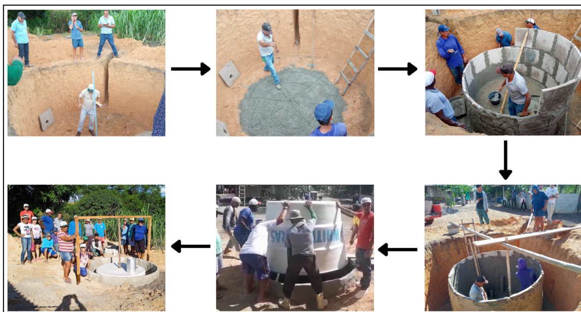
Figura 1. Construção do Biodigestor modelo Sertanejo
