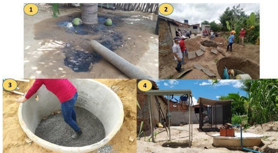
Figura 2. Processo de Implantação do canteiro da agrobiodiversidade com instalação de estruturas para o reuso de águas cinzas (Bioágua Familiar).
