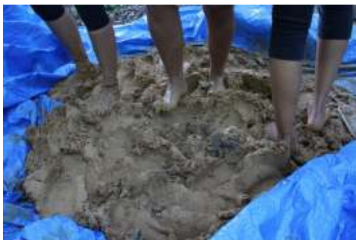
Figura 1: Pisoteio da massa para o banco de Hiperadobe.
