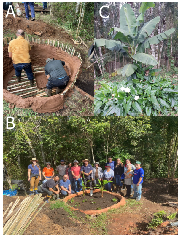
Figura 2 - A) - Construção da Wetland com solo cimento e estrutura de bambu; B) -Instalação completa e encerramento da oficina; C) - seis meses após o início de uso da Wetland.
