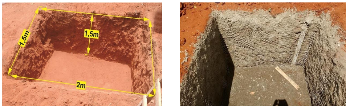
Figura 2: Dimensões da escavação (à direita) e; registro fotográfico da escavação impermeabilizada (à esquerda). Fonte: Arquivo Instituto Terraviva (2017)
