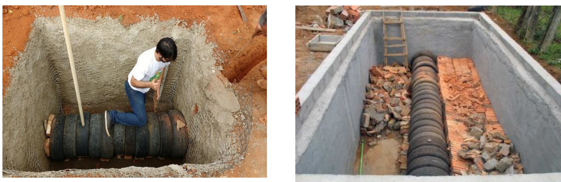
Figura 3: Montagem do “tubo” feito com pneus de descarte (à esquerda) e; preenchimento com os materiais filtrantes (à direita). Fonte: Arquivo Institucional (2018).
