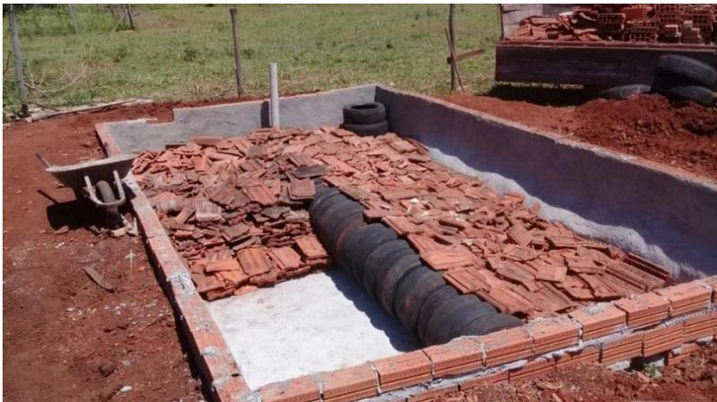
FIGURA 1. Canteiro Bioséptico impermeabilizado em alvenaria; Construção do duto de pneus e extrator de resíduo líquido e preenchimento com cacos de telhas e blocos de cerâmica.
