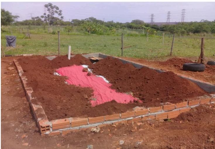
FIGURA 2. Camada de pedra brita recoberta com a manta sintética (TNT) e a dispersão da camada de terra vermelha.
