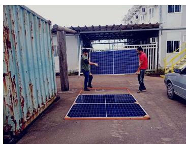
Figura 1 - Painel fotovoltaico e o suporte
