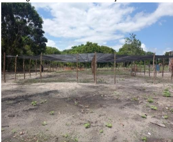
Figura 1– Início da construção da UPE
