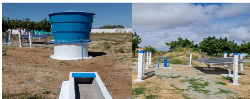
Figura 1 (A-B): Reservatório elevado e bomba para o sistema de irrigação acionada por placas solares.
