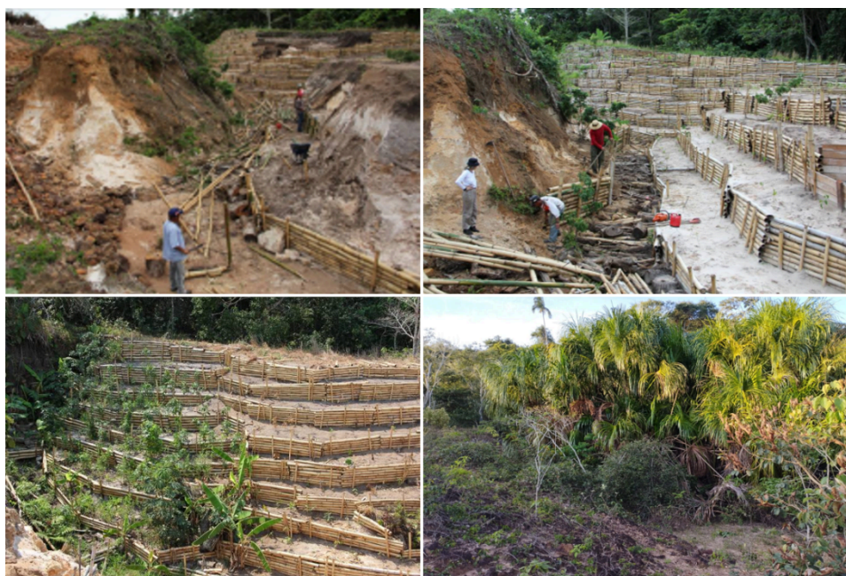
Figura 2. Voçoroca da Parede do processo de erosão à recuperação da área degradada.
