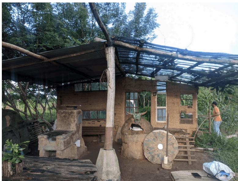
Figura 3 - Cozinha agroecológica após cobertura com telhas de zinco.
