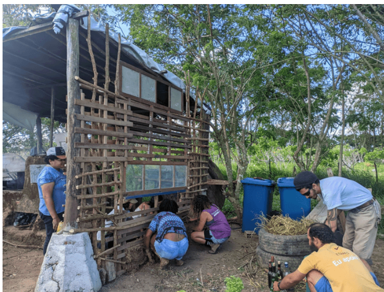
Figura 2 - Atividade de construção da primeira parede, no método pau a pique.
