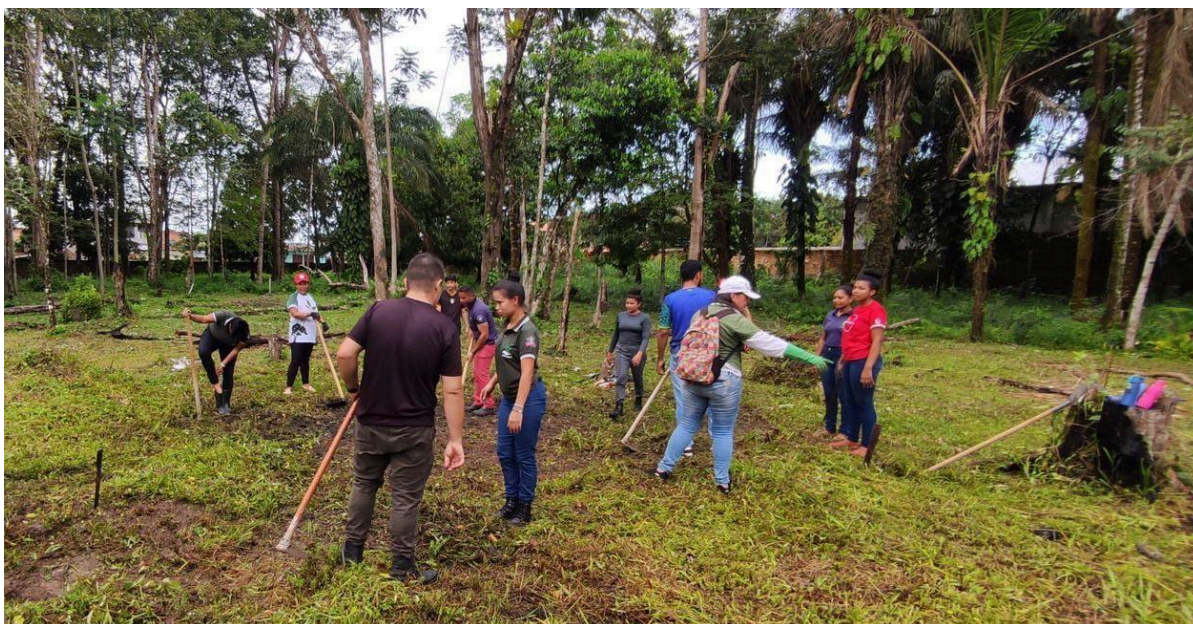
Figura 2 - Limpeza da área. Fonte: Autores (2023).
